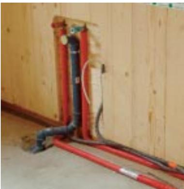
Rohre und Leitungen für Sanitär-, Elektro- und Heizungsinstallation werden in Ausfräsungen verlegt
