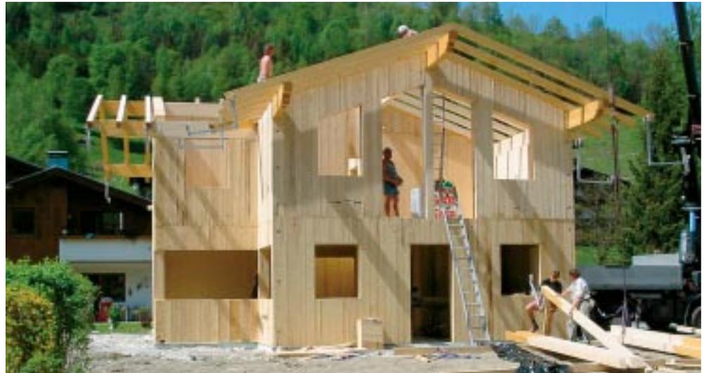
und Befestigung des Wandelements, das im Fußbereich eine passende Ausfräsung aufweist und von der Innenseite her mit der Schwelle verschraubt wird.
