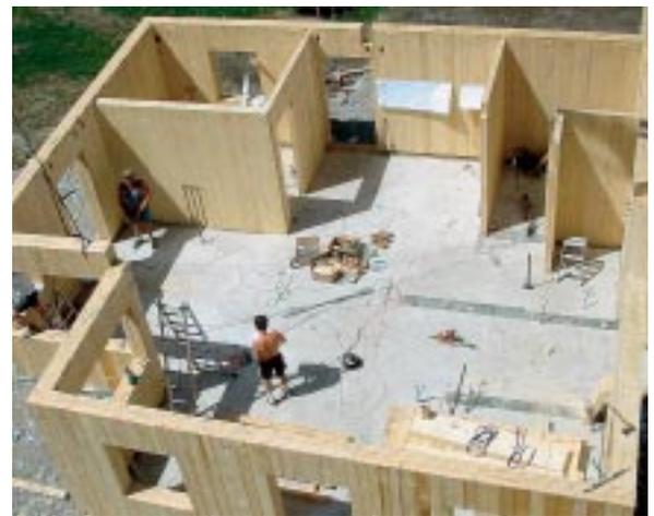
Oben: Montage eines zweigeschossigen Wohnhauses. Der Abbund erfolgt in der Regel geschossweise
