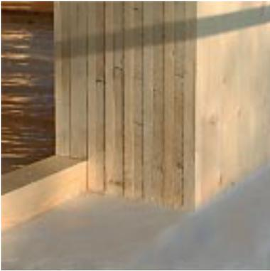
Wandanschluss an der ausnivellierten Schwelle: Gut zu erkennen sind die 3 x 3 mm Nuten auf den einzelnen Brettern, die ein zusätzliches Luftpolster innerhalb der Wand bilden
