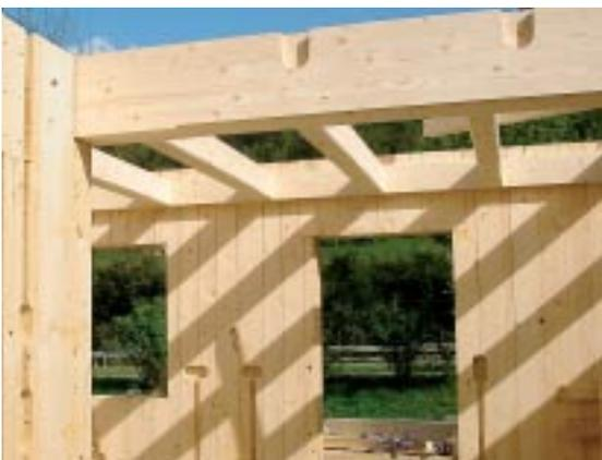
Wandelement mit eingehängten Deckenbalken und Unterzug
