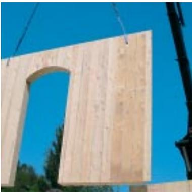
Element mit Türbogen während der Montage: Da alle Öffnungen CNC-gefräst werden, stellen Sonderformen kein Problem dar
