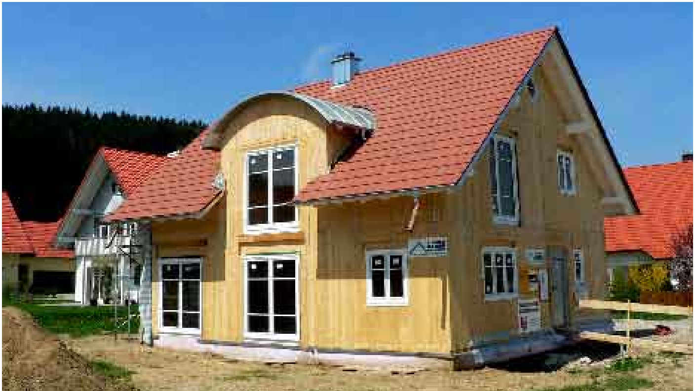
Das MHM-System bildet die Tragkonstruktion dieses Wohnhauses
