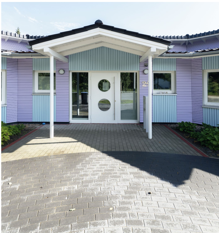
Die Eingangsbereiche sind barrierefrei ausgestattet. Die Holzwände stehen auf einem Betonsockel. Außerdem schützt ein großzügiges Vordach vor Bewitterung.
