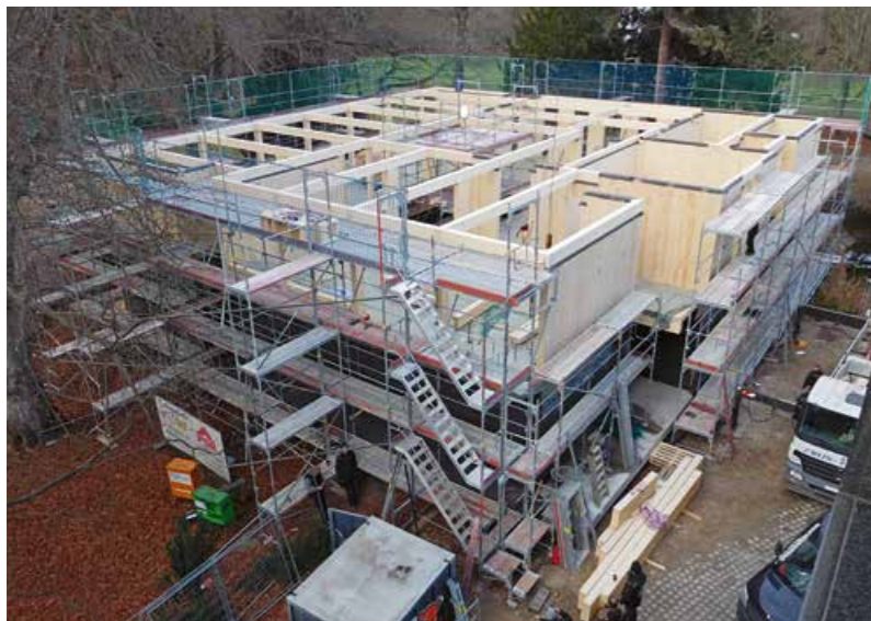
◀ Blick auf die offene Konstruktion in der Bauphase. Gut zu erkennen: der Wechsel zwischen großformatigen Elementen in den fixen und Stützen mit Unterzügen in den flexiblen Nutzungsbereichen
