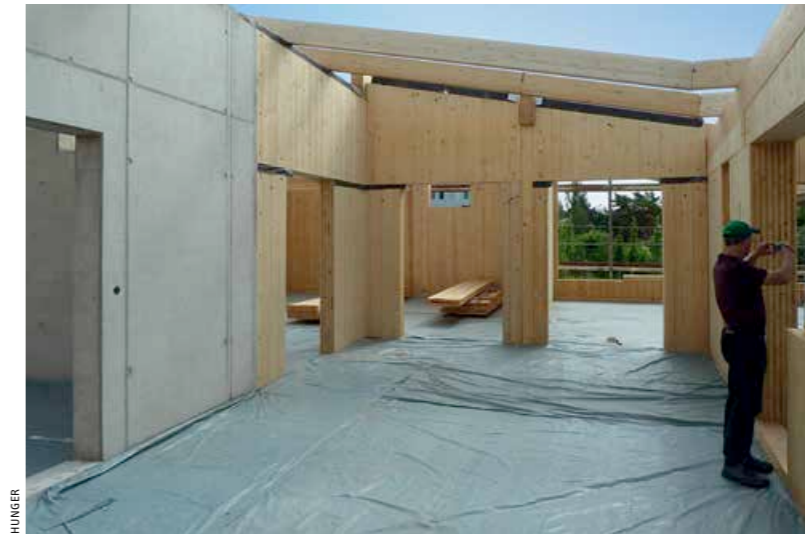
◀ Der in der Luft hängende Sparrenstoß
