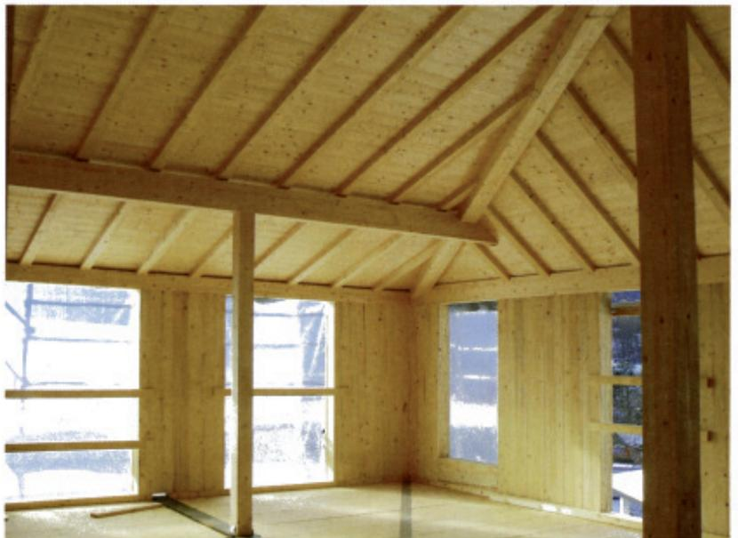
Bereits nach sechs Tagen war der Rohbau mit dem MHM-System abgeschlossen
