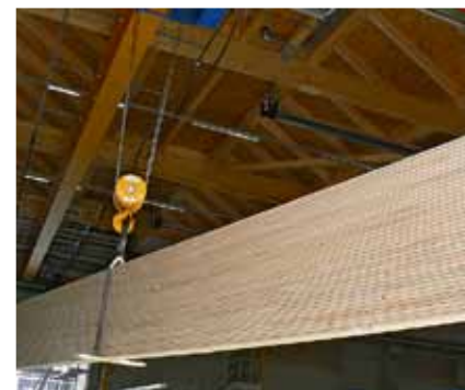
Ein PHE-Bauteil ist fertig für die Verladung
