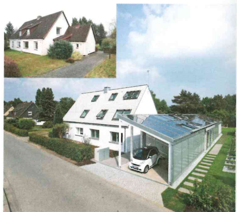
▲ Vorher, nachher: Schon die Optik des Licht-Aktiv-Hauses spricht für sich. Jetzt wurde es prämiert
