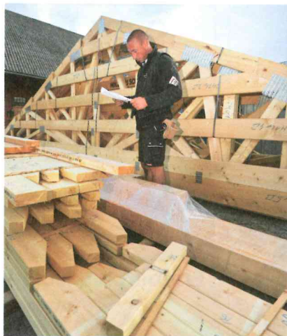
▲ Schnoor zufolge wächst der Bedarf an Nagelplattenbindern. Das Unternehmen baut seine Fertigungskapazitäten daher aus
