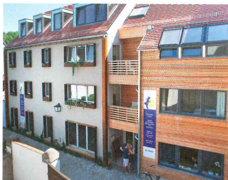
▲ Ein Weimarer Hotel aus Massivholzmauern hat den Thüringer Holzbaupreis 2013 eingheimst
