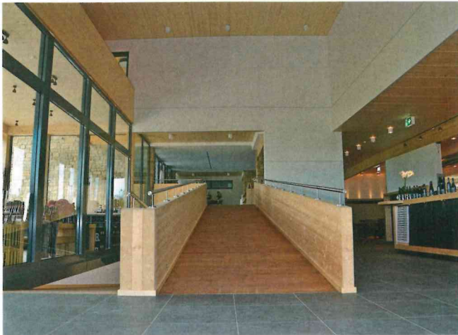
Rampen binden die Split-Level-Geschosse barrierefrei an. Durch die Vertikalität entstehen neue Ein- und Ausblicke.
