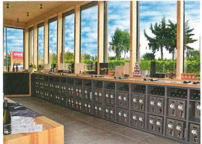
Im Weinverkauf werden die Erzeugnisse des Winzers angeboten. Die filigrane Pfosten-Riegelkonstruktion aus Nadelholz wirkt offen und freundlich.
