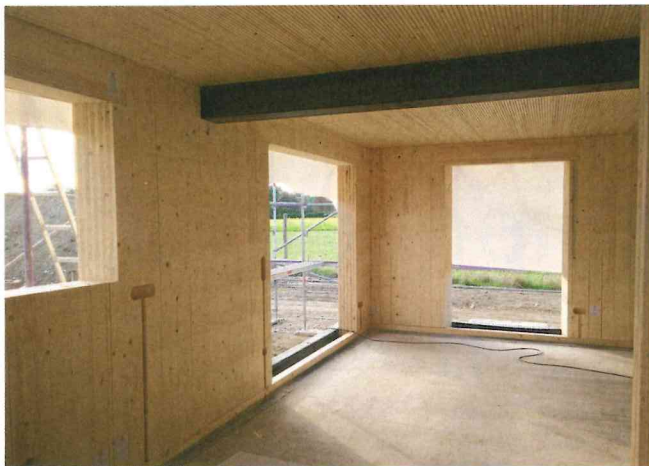
Kreuzweise vernagelte Nadelholzbretter ergeben die vorgefertigten Massiv-Holz-Mauer-Elemente: nachhaltig, vielseitig und für ein angenehmes Raumklima.
