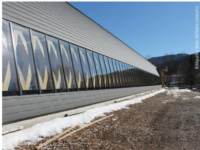
Den Abschluss bildet eine Eindeckung mit Alu-Schindeln, die aus mehrlagigen, verformbaren Aluminium-Legierungen bestehen und zu 100 % recycelbar sind. Für die nur 0,7 mm dünnen und vergleichsweise leichten Schindeln gibt es eine 40-jährige Materialgarantie.
