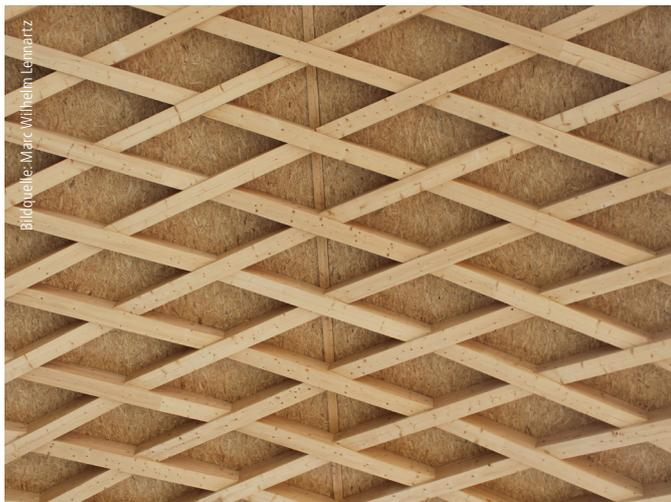
Auf das Schalentragswerk schraubten die Zimmerer eine sichtoffene OSB-Schalung von 15 mm Dicke, die zugleich – da an den Stößen mit Klebebändern abgedichtet – als luftdichte Ebene fungiert. Vorher hatte man die einzelnen Platten über einen Gehrungsschnitt an die Wölbung des Zollinger-Tragwerks angepasst.
