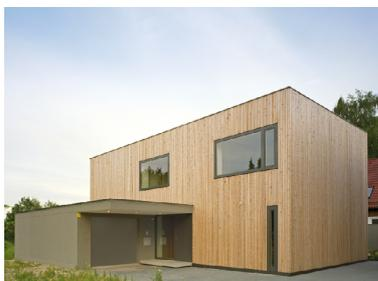
übergänge differenziert, durch einen recht neuen, seit letztem Jahr auch allgemein bauaufsichtlich zugelassenen Baustoff: Die einschalige Massiv-Holz-Mauer aus kreuzweise verpressten Fichtenbrettern kommt ohne Leim oder synthetische Dämmfolien aus. Mit Hilfe des innovativen Wandaufbaus lässt sich aus den vorteilhaften Eigenschaften des Baustoffs Holz der größtmögliche Nutzen für Raumklima, Wärmeschutz, Dichtigkeit und Feuchtigkeitsregulierung ziehen.
