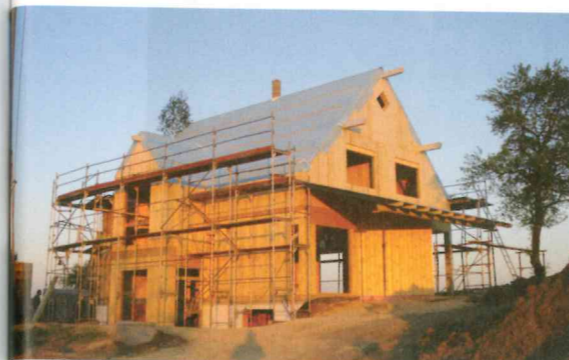
In Zusammenarbeit mit der Massiv-Holz-Mauer EntwicklungsGmbH und der Zimmerei Mayr+Sonntag GmbH plant und betreut Rehm fast ausschließlich Massiv-Holz-Mauer Häuser.
