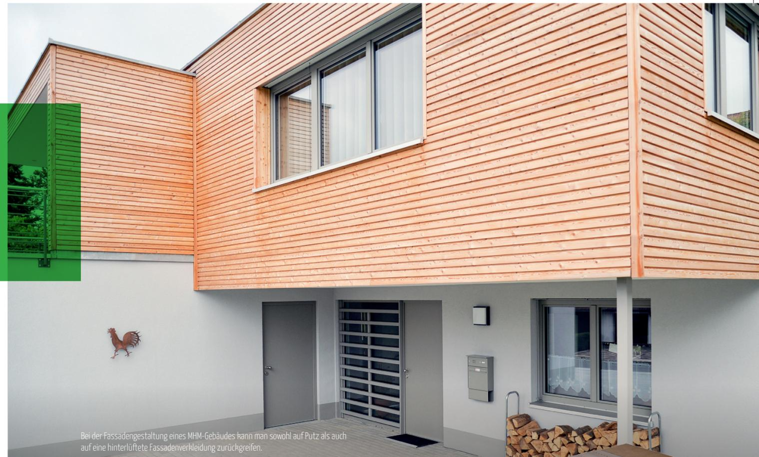
Bei der Fassadengestaltung eines MHM-Gebäudes kann man sowohl auf Putz als auch auf eine hinterlüftete Fassadenverkleidung zurückgreifen.
