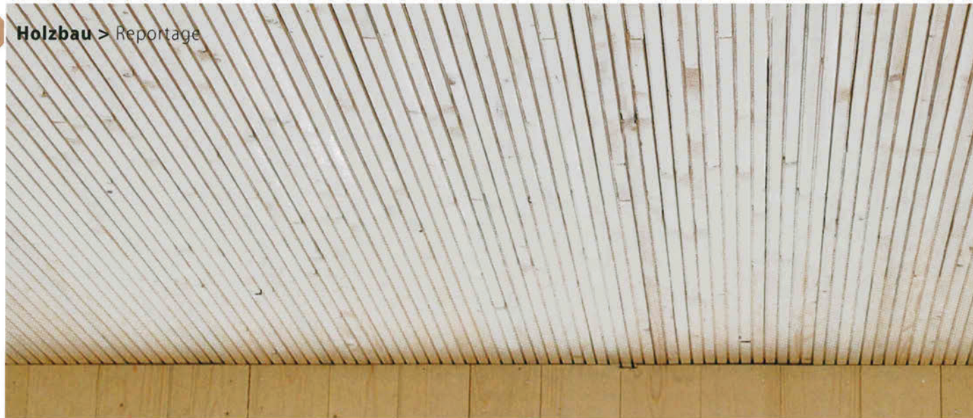
Die Profil-Holz-Elemente bestechen mit schöner Optik und sorgen für eine ausgezeichnete Raumakustik
