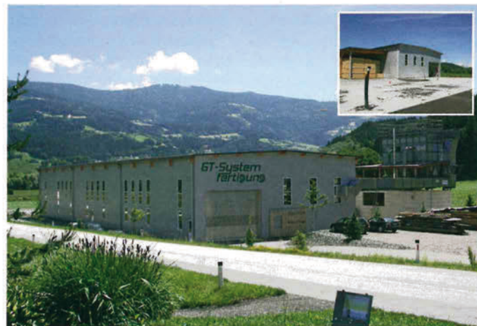
Die Produktionshalle von GT-Systemfertigung: Auf der Rückseite befinden sich bereits die Fundamente für den Zubau (s. kl. Bild)
