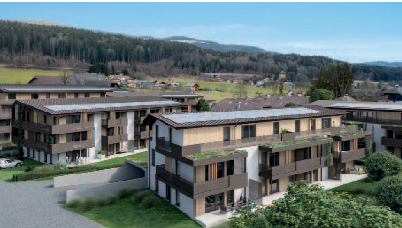
▲ Die Wohnungen haben zwischen 52 und 107 m 2 Wohnfläche, die verschiedenen Häuser bis zu vier Holzgeschosse
