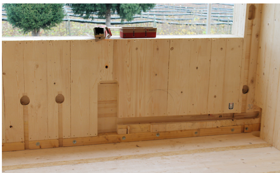
Der Abbund erfolgt vollautomatisch. Die Elemente können inklusive der Fräsungen für Installationen zur Baustelle geliefert werden.
