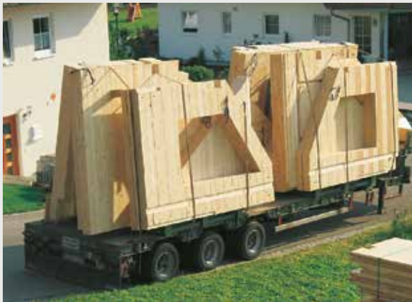
1. Доставка стеновых элементов
