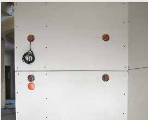
5. Индивидуальная обшивка стен, например, гипсокартонными плитами или глиняными строительными листами
