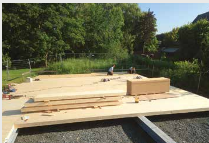
Пол из профилированных деревянных элементов
