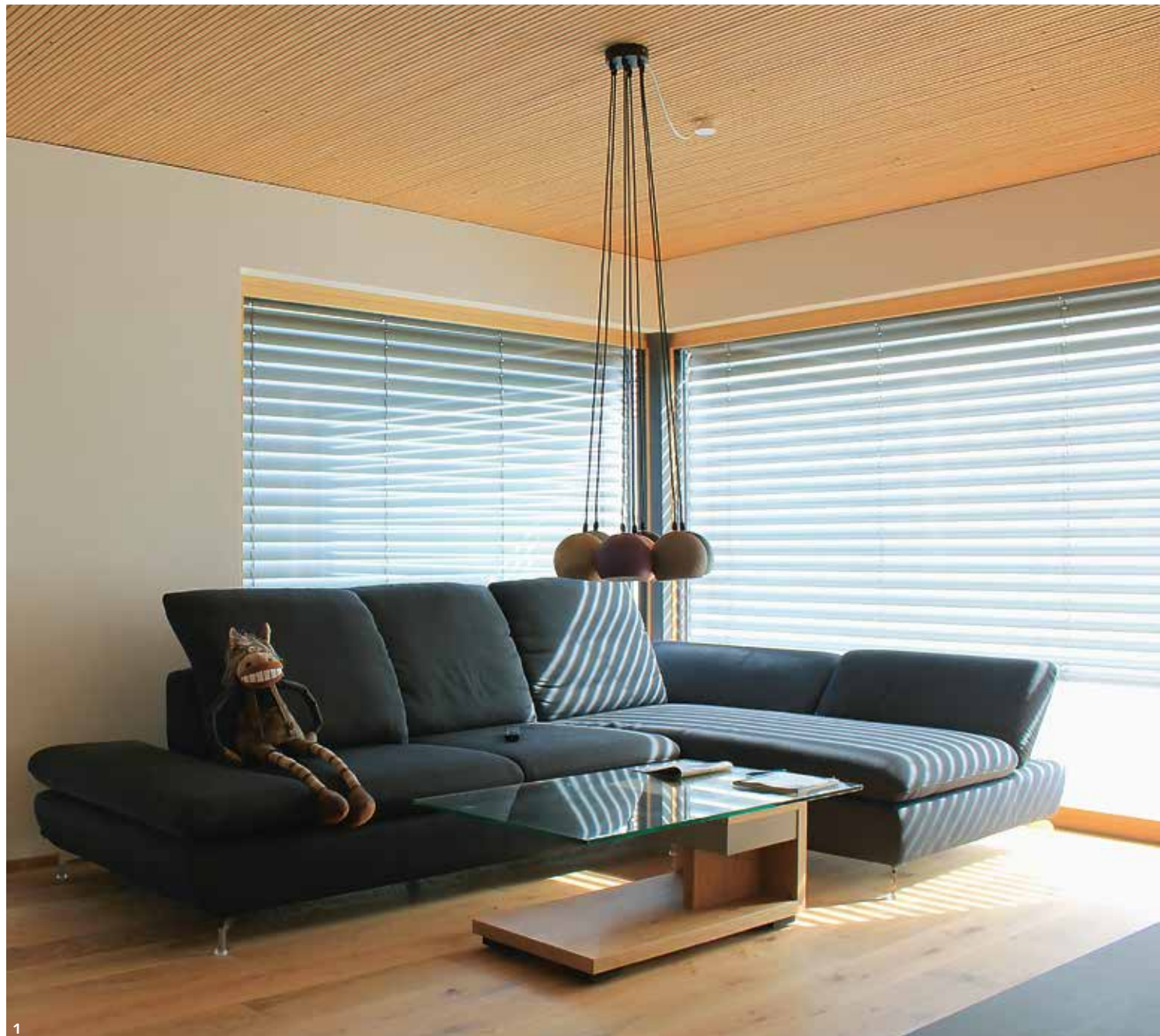
Потолок из профилированных деревянных элементов (акустический профиль)
