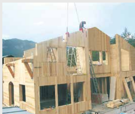
3. Монтаж неотделанной постройки
