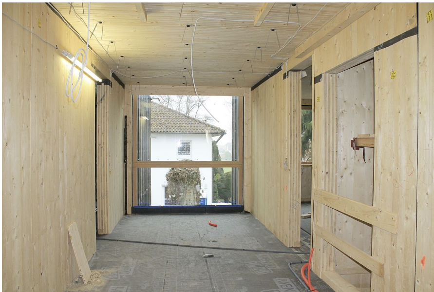
Die massiven Holzelemente kommen ohne Leim aus. Ihre einzelnen Brettlagen sind mit Aluminiumnägeln untereinander verbunden.
