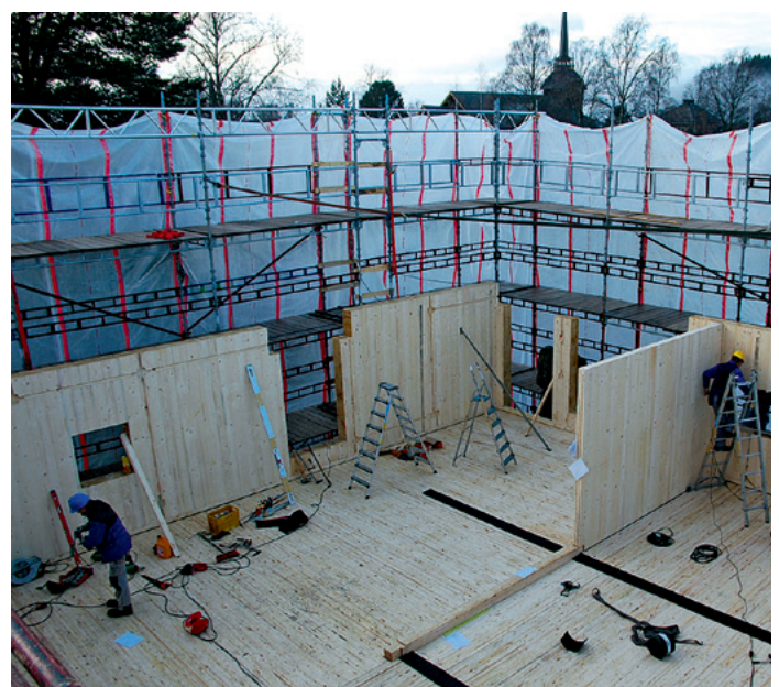
Innenansicht: Es werden Massiv-Holz-Mauern von MHM-Entwicklung eingesetzt
