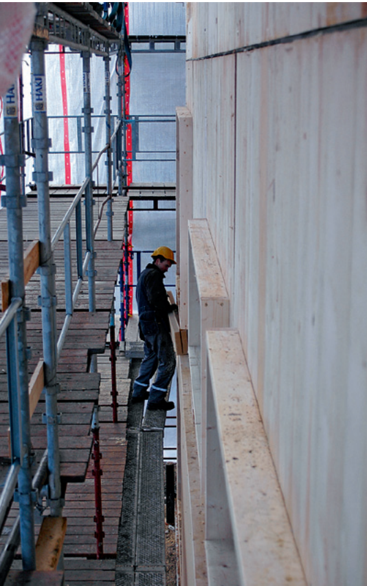
Außenansicht der Massiv-Holz-Elemente auf der Baustelle in Norwegen
