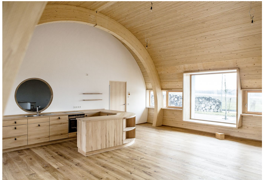
Die profilierten Oberflächen der Dach- und Deckenelemente sorgen für eine verbesserte Raumakustik.
