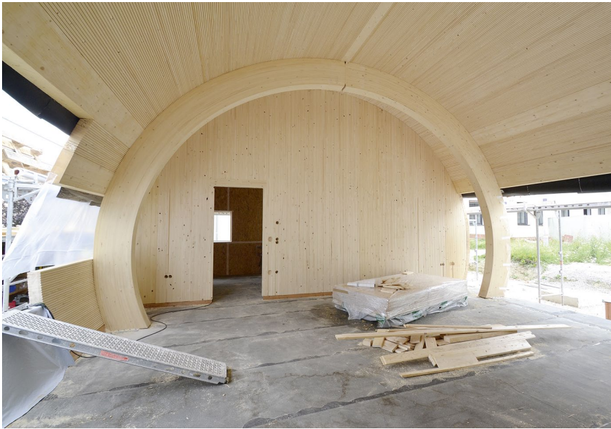
Brettschichtholzbögen bilden die tragende Grundstruktur des tonnenförmigen Neubaus.
