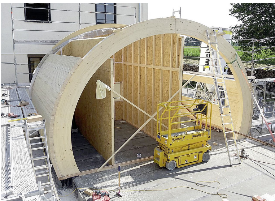
Nach dem Richten montierten die Zimmerleute die PHE-Elemente von außen auf die hölzernen Bögen.
