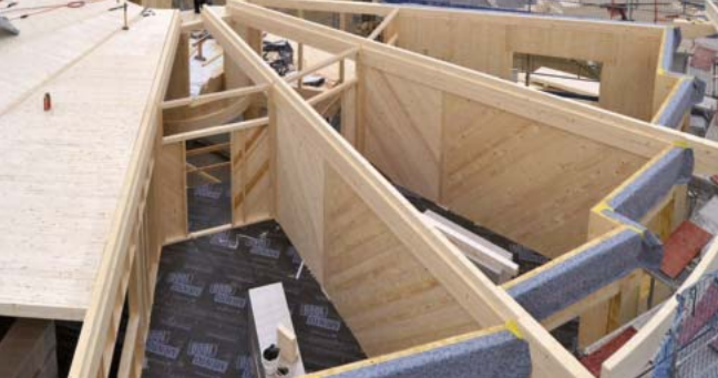
Holz, massives Holz, wohin man blickt: Das Sägezahn-Gebäude von Hundegger in Hawangen in diversen Bauphasen
