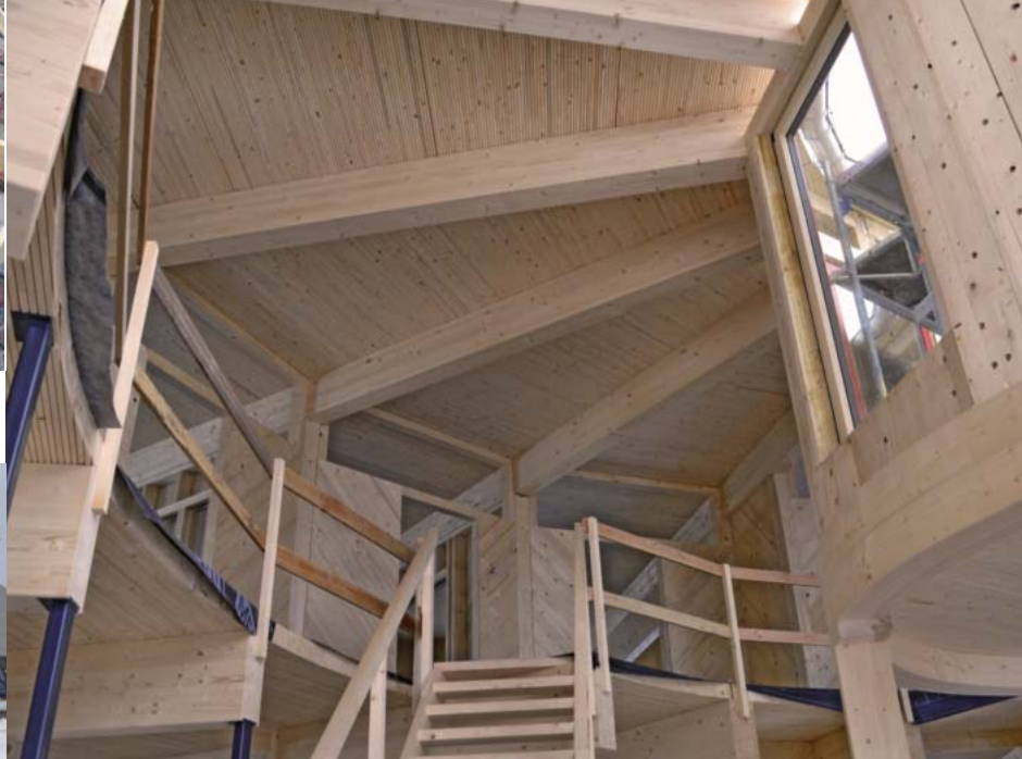
Holz, massives Holz, wohin man blickt: Das Sägezahn-Gebäude von Hundegger in Hawangen in diversen Bauphasen
