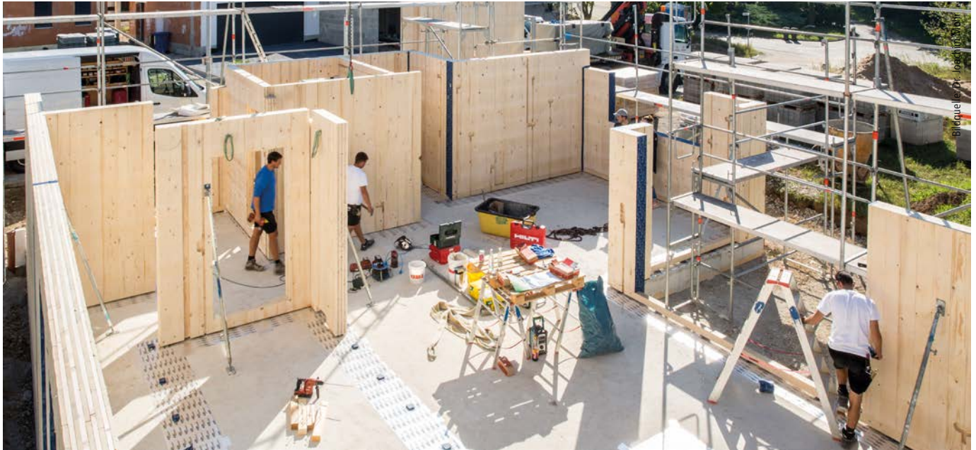
Montage der Massiv-Holz-Mauer-Elemente auf der Baustelle
