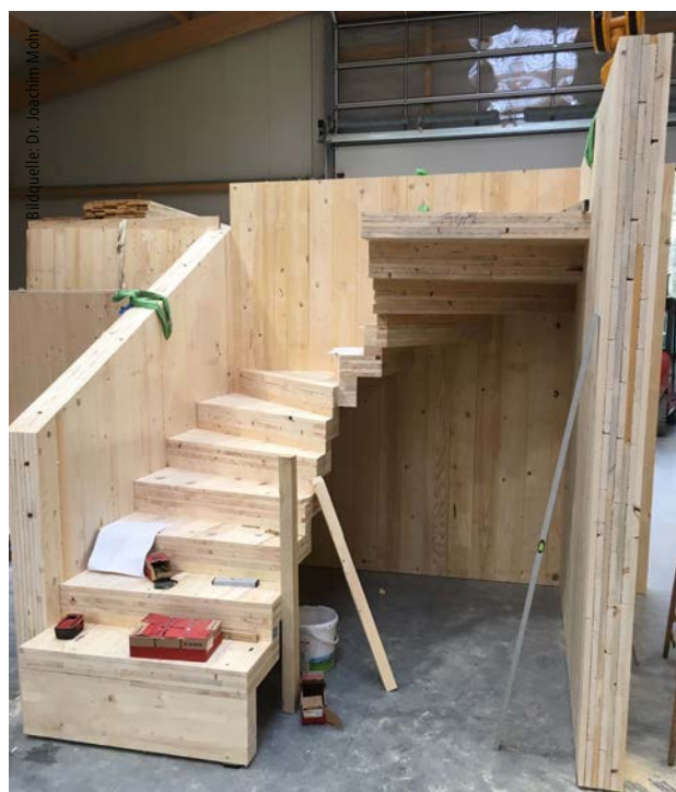
Die Stufen des Treppenmoduls werden heute im Nesting aus Fenster- und Türausschnitten gefertigt.
