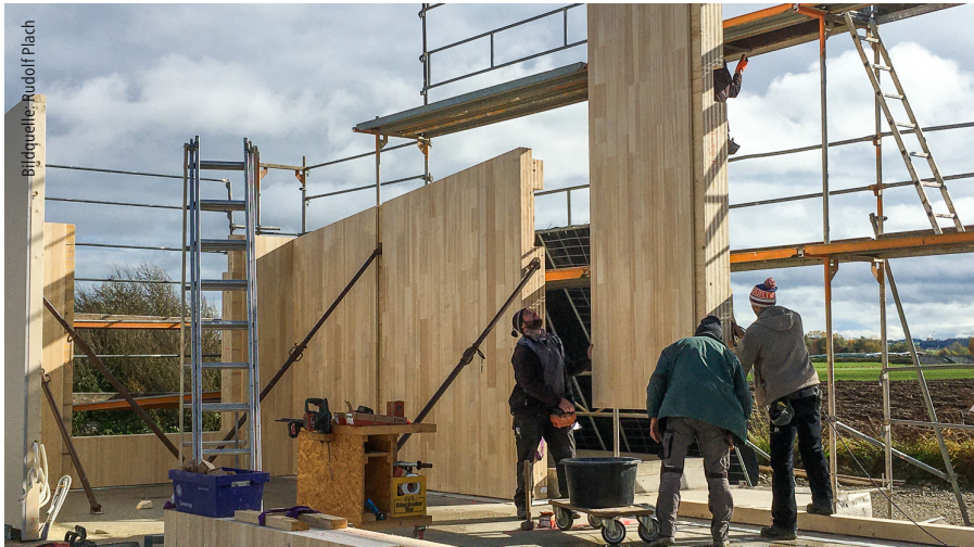
Für die Stöße der vorgefertigten Elemente, die im Holz möglichst nicht zu erkennen sein sollten, gibt es Aussparungen in der Deckschicht, in die nach der Elementmontage ein Deckbrett eingesetzt wird. Diese Bretter sind dank präziser Vorfertigung so passgenau, dass sie nicht auffallen, ihre Verschraubung liegt im Stoß und ist ebenfalls kaum zu sehen.
